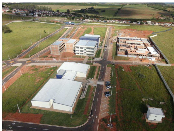
Vista geral da unidade
