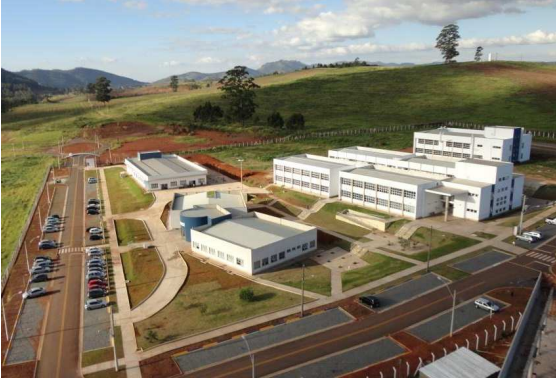
Pavilhões A, B, C, D e E
