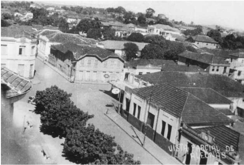
Vista parcial da praça central de Alfenas mostrando os prédios (indicados): à direita, de Edmundo Pereira e, à esquerda, de Antônio Carlos de Carvalho; logo em frente, o alpentre citado
