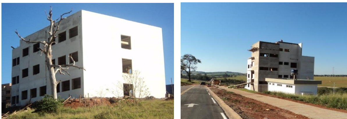
Figura 2. Fotos do prédio no câmpus II da UNIFAL-MG em Alfenas - Jul/2012
