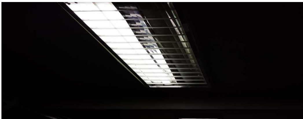
Fig. 31 – Luminárias utilizadas para o almoxarifado do Instituto de Química
