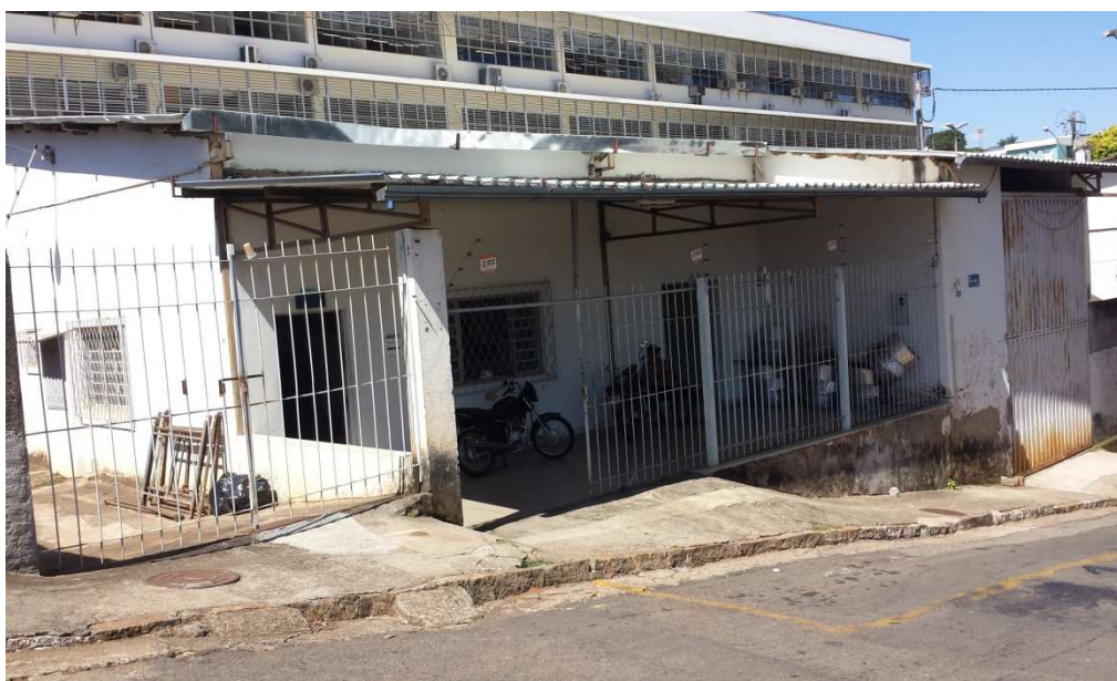
Fig. 11 – vista externa do prédio do Almoxarifado Central da UNIFAL-MG
