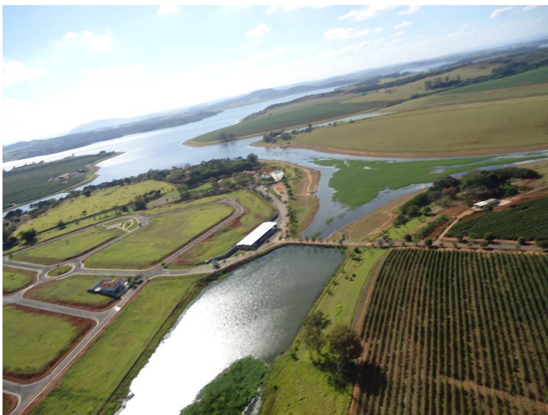
Figura 30 – Vista do lago de Furnas em Alfenas, à esquerda loteamento Condomínio Residencial Porto Seguro; ao centro, a Rampa Náutica e o Clube Náutico.
