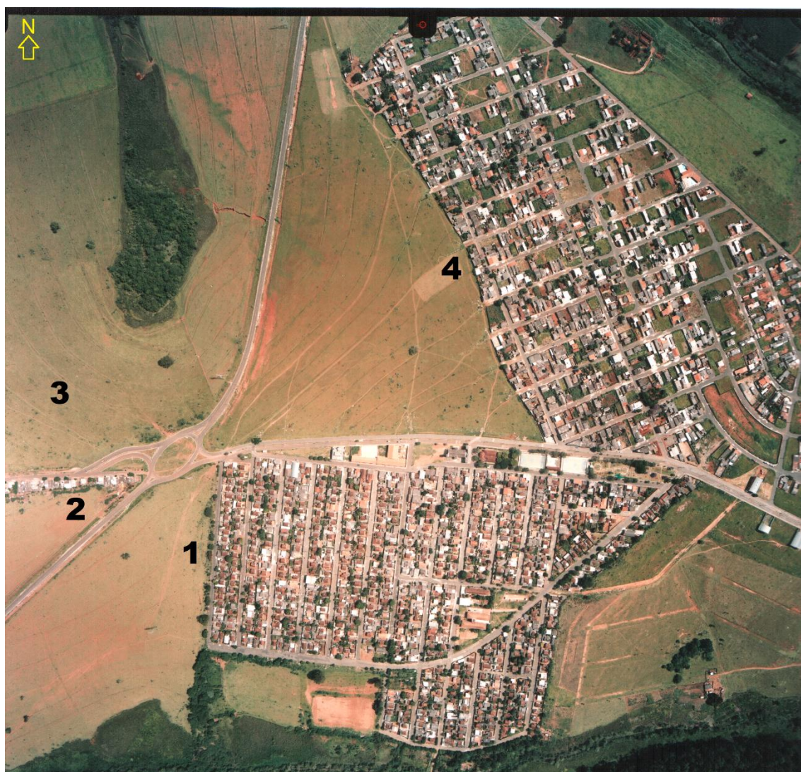
Figura 18 – Fotografia aérea ortogonal obtida por avião. 1- Bairro Pinheirinho (Conjunto Habitacional Francelino Pereira); 2- Parte inicial do Corredor Santa Clara; 3- Local das futuras instalações do Campus II da Unifal 4- Bairro Recreio Vale do Sol. Escala original 1:6.000; 2006.
