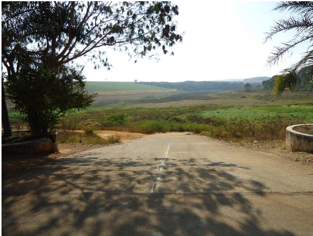
Figura 32 – Rampa Náutica, com o nível de água baixo em 2017. Fonte: Evânio S. Branquinho, ago. 2017.
