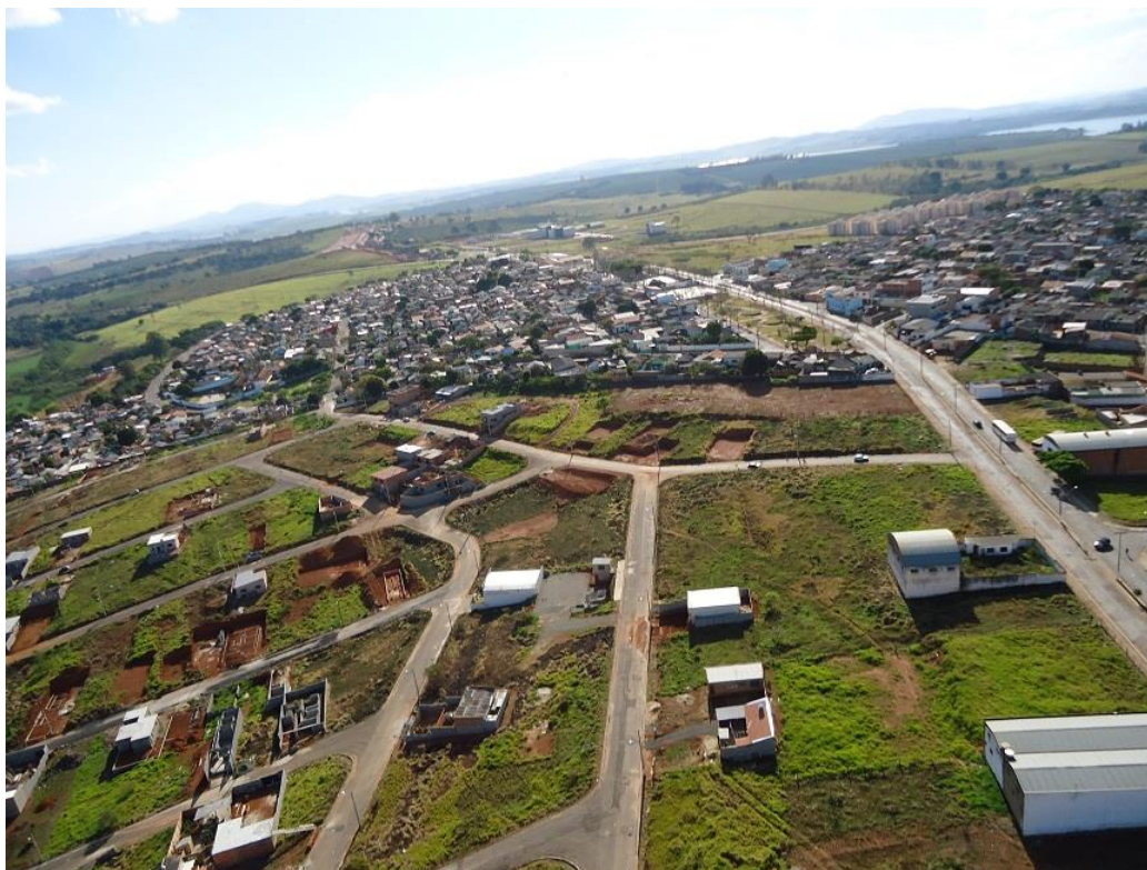
Figura 27 – Vista aérea do novo loteamento Vale Verde, ao fundo bairro do Pinheirinho, à direita avenida Jovino Fernandes Salles.
