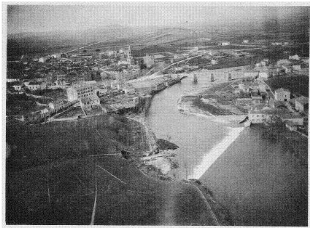
Figura 1 - Labruguiere, França, fotografia aérea com pipa, tomada em março de 1889 por Arthur Batut Fonte: Blake, 2010.
