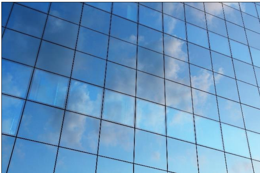
Figura 3 – Fachada com cortina de vidro
