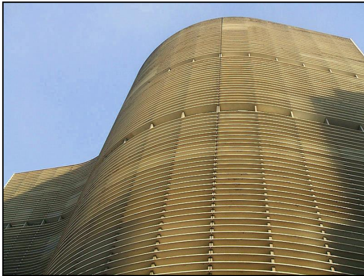
Figura 19 – Exemplo de quebra-sol limitador
