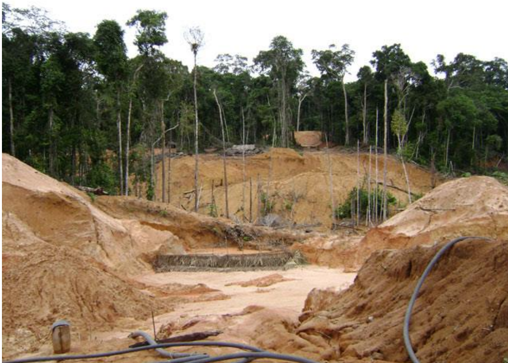
Imagem 2 - Área movimentada por desmonte de bico-jatos
