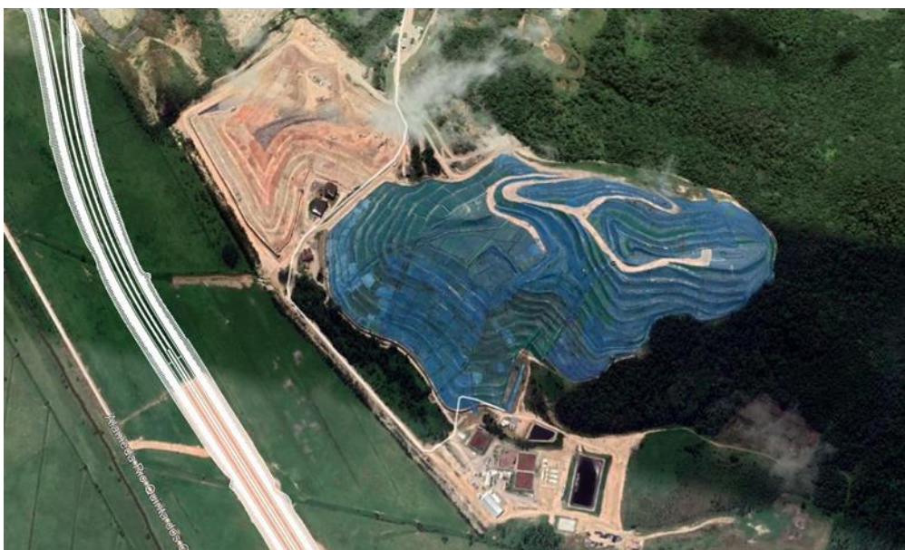
Figura 14 - Área do aterro sanitário de Tijuquinhas.
