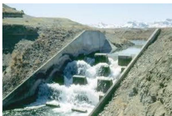
Figura 20: Exemplo de uma estrutura com macrorrugosidades – Rampa com blocos (extraído de USDA, 1981).
