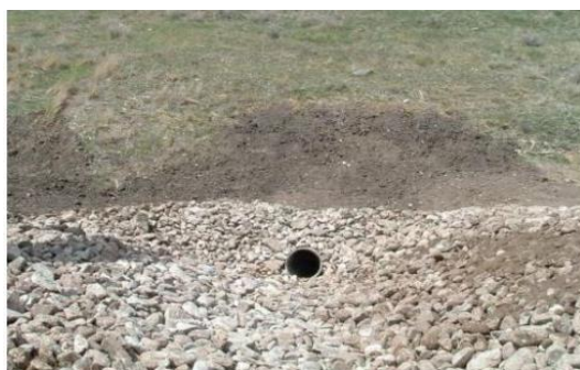
Figura 21: A esquerda tapete de enrocamento à saída de uma passagem hidráulica (extraído de FEMA, 2010). A direita utilização do tipo colchão gabião. Fonte: Deflor Engenharia.
