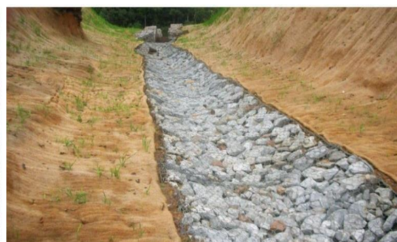
Figura 21: A esquerda tapete de enrocamento à saída de uma passagem hidráulica (extraído de FEMA, 2010). A direita utilização do tipo colchão gabião. Fonte: Deflor Engenharia.
