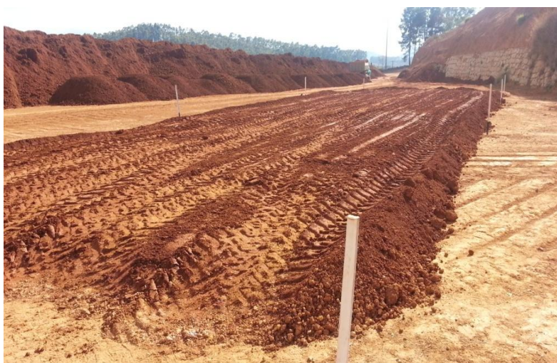
Figura 15 - Pilha já construída.
