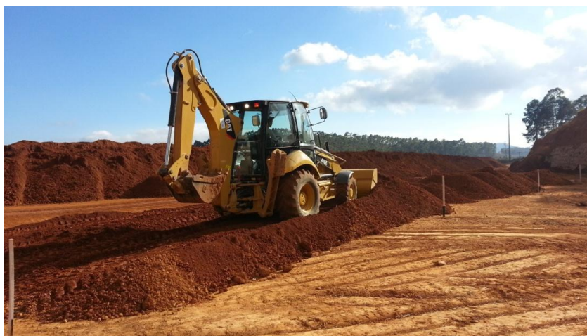
Figura 17 - Retroescavadeira CAT 416E realizando o espalhamento da bauxita.
