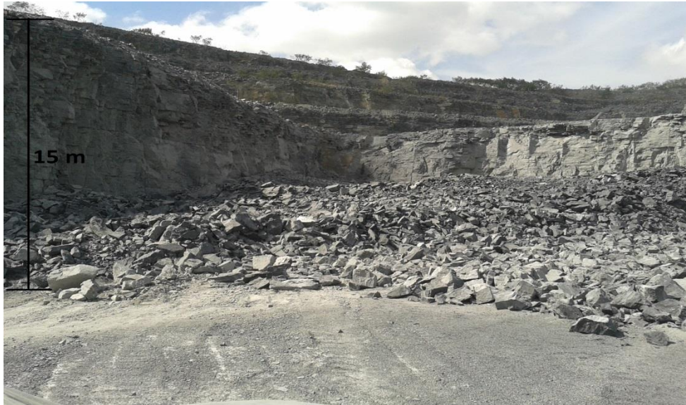
Figura 5-Resultado do desmonte utilizando o Plano de Fogo A.
