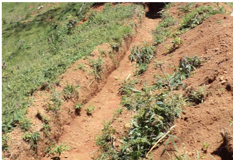
Figura 9: valeta construída após a leira de proteção formada por material provinda do top-soil.
