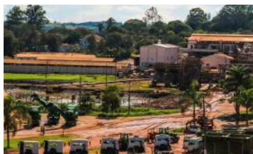
Estação de Tratamento e Reaproveitamento de água
