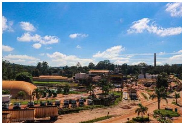
Planta Agroindustrial da Usina Monte Alegre, localizada em Monte Belo, em 2020
