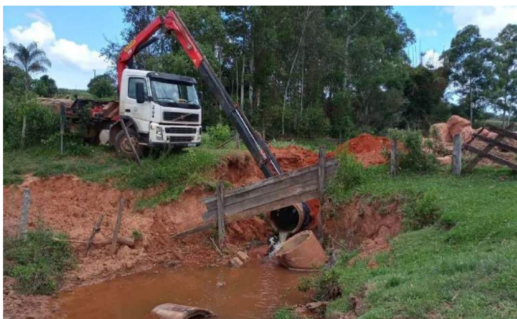
Obra de recuperação de galerias e pontes, em Areado, em 2021
