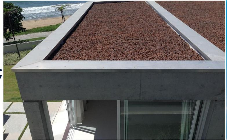
**Figura 3: Uso da argila expandida como isolante térmico**
