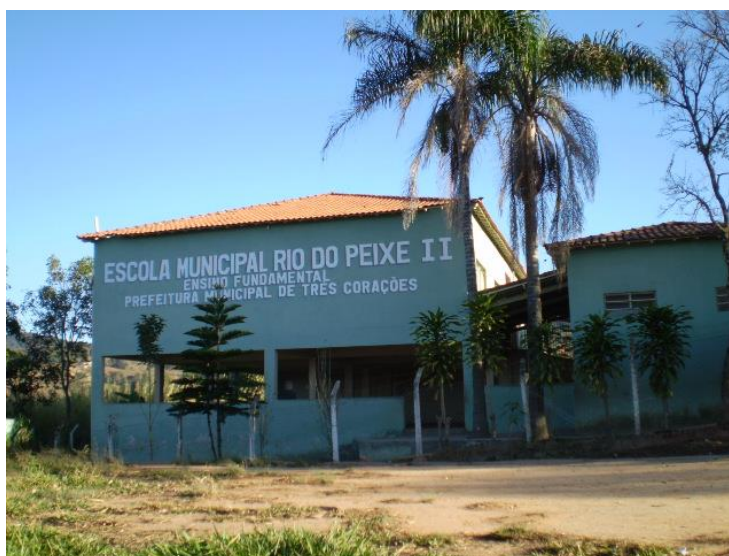
Figura 08: Vista parcial da Escola Municipal Rio do Peixe II, no bairro rural Rio do Peixe, Três Corações- MG.
