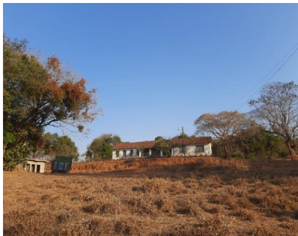
Figura 06- Antigo prédio da escola do bairro, sede atual da Associação dos Moradores do Bairro Gomes, no município de Areado/MG.
