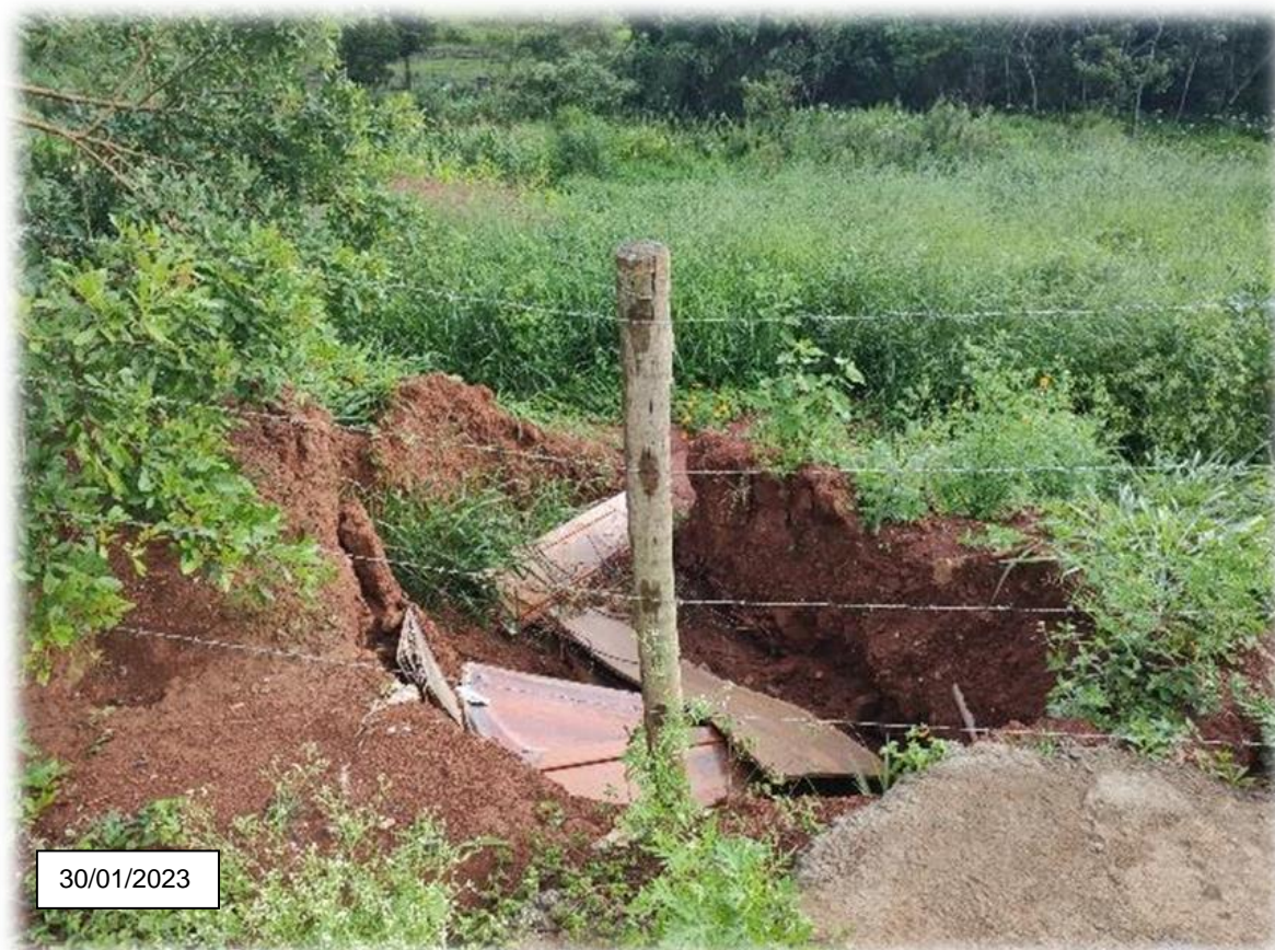
Figura 66 – Processo erosivo em área de preservação permanente no Residencial Cândido Alves
