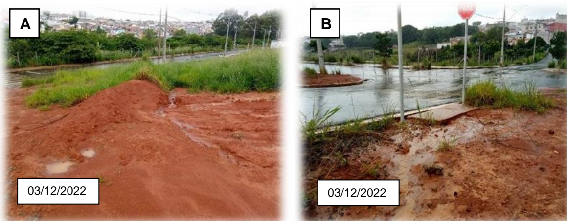
Figura 57 – Escoamento superficial e processos erosivos no Residencial Dona Anita
