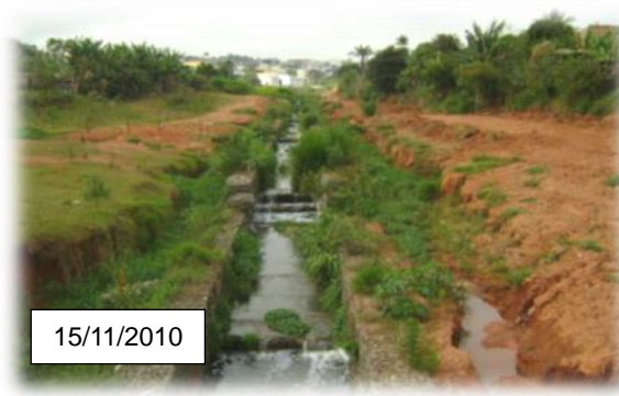
Figura 32 – Canal hídrico do principal do córrego do Pântano retificado
