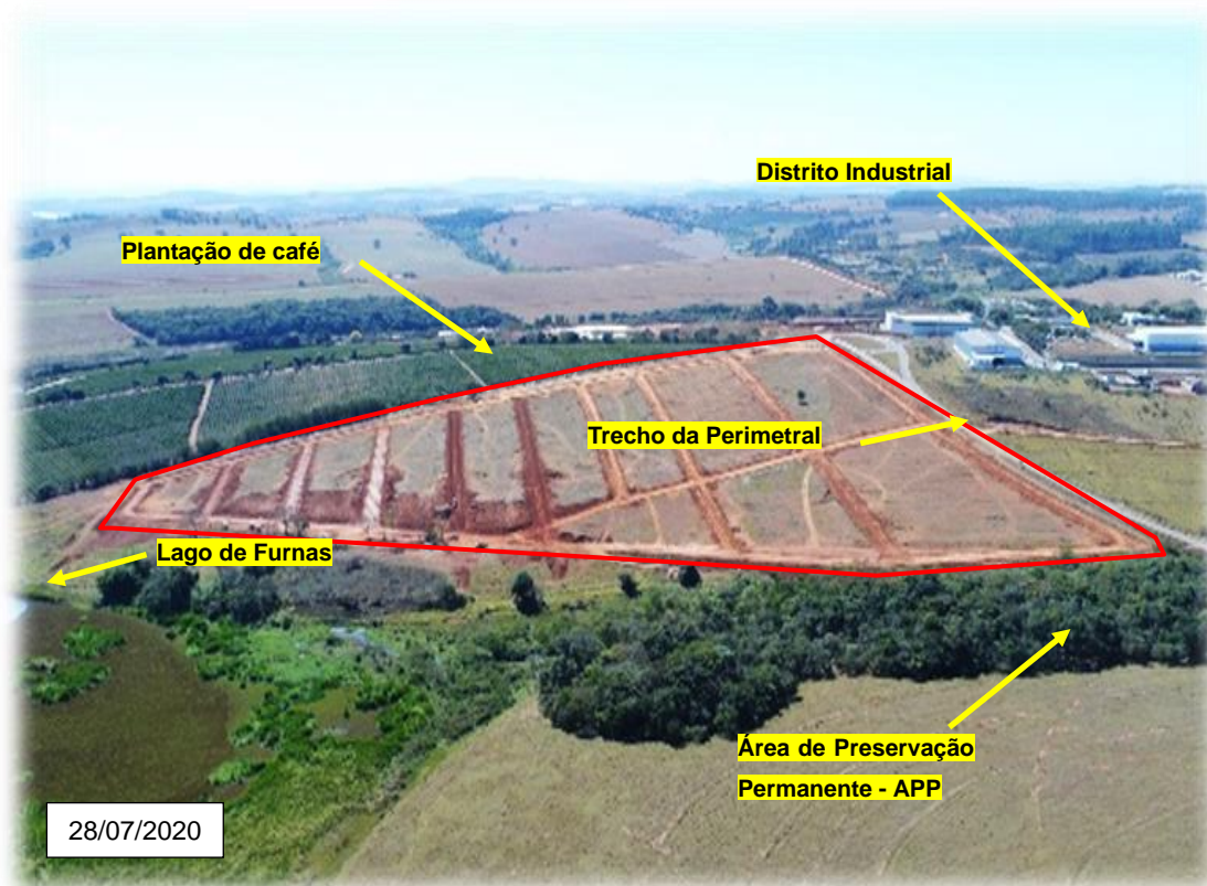
Figura 20 - Foto panorâmica registrada com drone do loteamento Jardim Nova Alfenas em fase de implementação.
