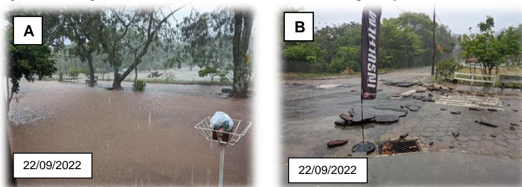
Figura 51 – Registro de enchente no bairro Jardim Boa Esperança
