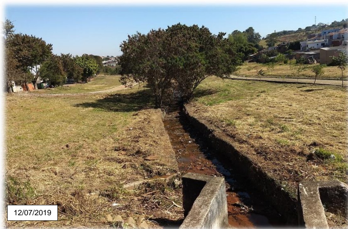
Figura 52 – Canal hídrico do córrego Boa Esperança retificado
