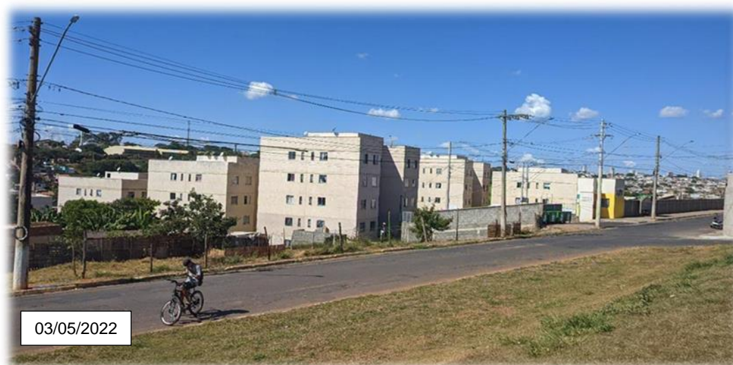
Figura 19 - Foto panorâmica do Residencial Tupã
