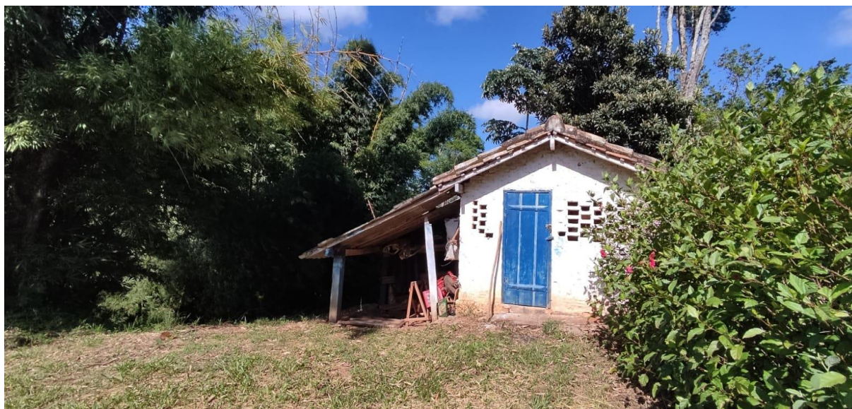
Fotografia 9 - Fotografia atual de onde teria sido a escola na Fazenda Campo Redondo
