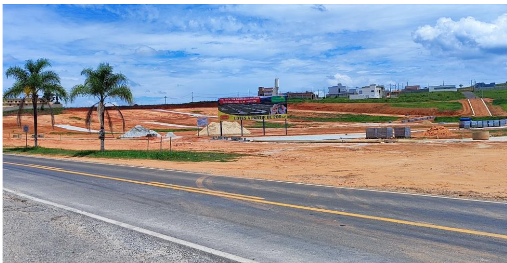
Figura 18: Loteamento em construção na entrada na cidade
