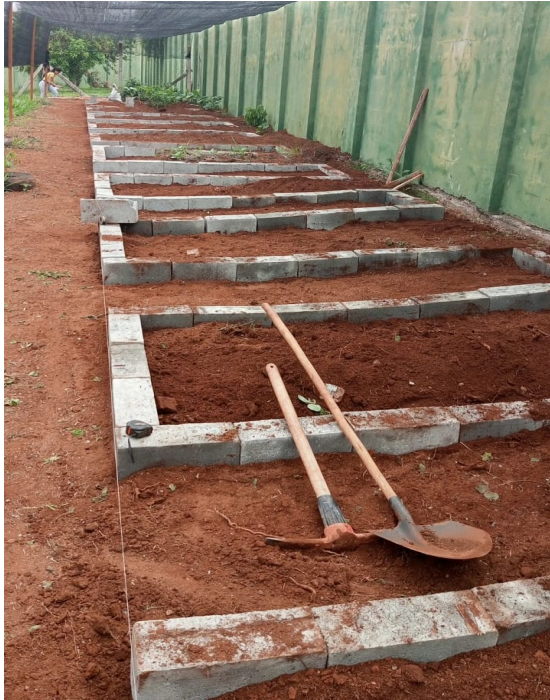
Figura 08 - Canteiros em construção
