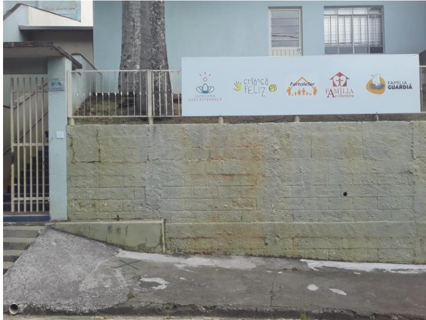
Figura 2: Foto da entrada do Centro Espírita
