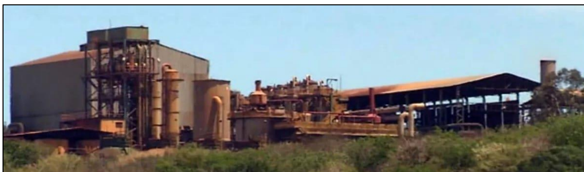
Figura 4 – Instalações da destilaria, desativada e abandonada, 2021.
