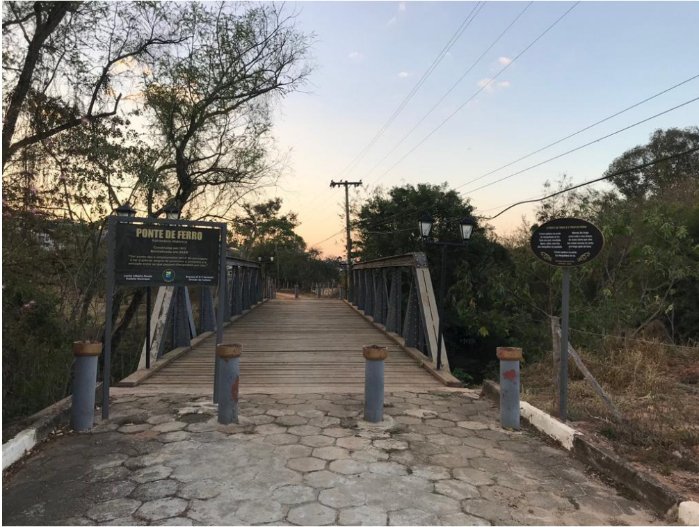
Figura 7 – Ponte de Ferro.
