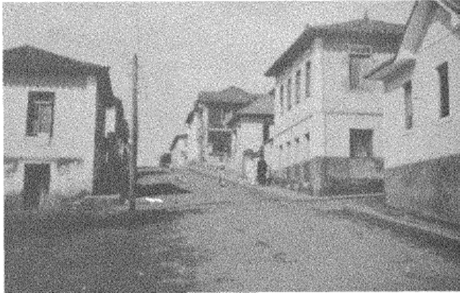
Imagem 4 - Vista da Rua Joaquim Carlos dos Reis.
