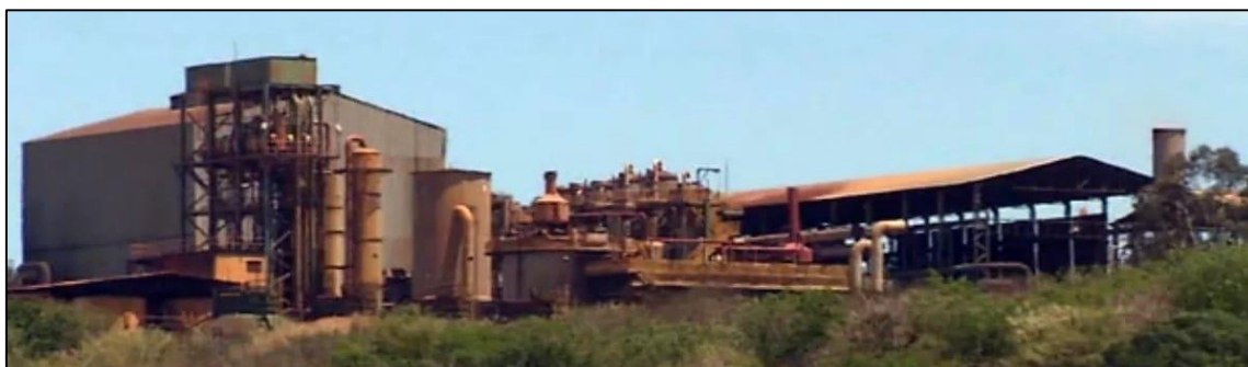
Figura 4 – Instalações da destilaria, desativada e abandonada, 2021.
