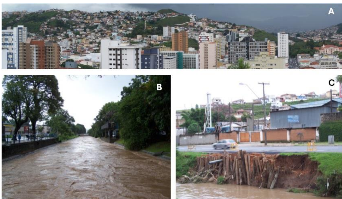
Figura 5 – A) Vista geral de ocupação em encosta na área urbana de Poços de Caldas. (B) Aumento da vazão de canal urbano com extravasamento por incapacidade do leito em conter o volume d'água drenado pelas vertentes. (C) Solapamento das margens com comprometimento das estruturas viárias que margeiam os canais.
