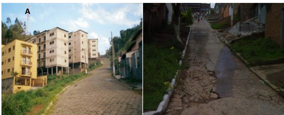
Figura 4 – Área urbana de Itajubá. A) Residencial assentado sobre terrenos com sérias limitações devido à declividade acentuada. B) Atividade erosiva em decorrência de ocupação em área com imitação ao uso urbano.
