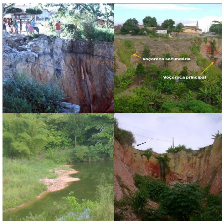
Figura 4. Voçorocas localizadas no bairro Urbis I em Eunápolis, Bahia. Fonte: De Albuquerque (2018).
