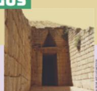
Triângulo de descarga: construção que permite descarregar as pressões exercidas por grandes pesos que se encontram por cima das portas dos túmulos e das cidadelas.
