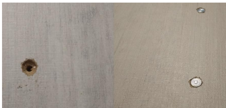
Figura 20 - Alojamento e prego colocado e alinhado
