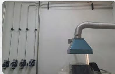
Está em execução a instalação das redes de gases especiais (Ar Sintético, Nitrogênio, Acetileno, Acetileno de Alto Pureza, Óxido Nitroso, GLP, Argônio, Hélio e Hidrogênio + Argônio) para funcionamento dos equipamentos de pesquisa instalados no prédio de laboratórios LABMAT do *campus* de Poços de Caldas. O valor do investimento foi de **R\$179.600,00** (cento e setenta e nove mil e seiscentos reais).
