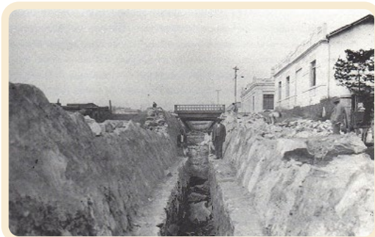
Figura 09 – Canalização de cursos d'água em Belo Horizonte-MG. Fonte Borsagli (2010)
