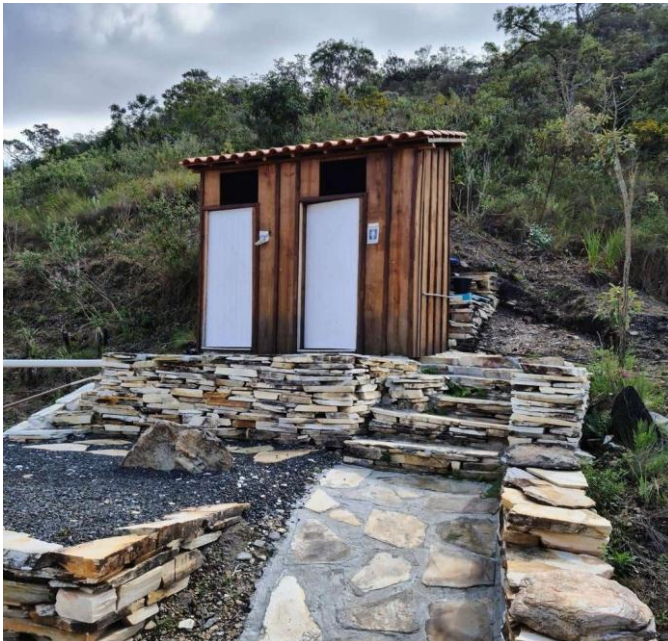
FIGURA 5 – Banheiros com fossa séptica no Complexo do Paraíso Achado.
