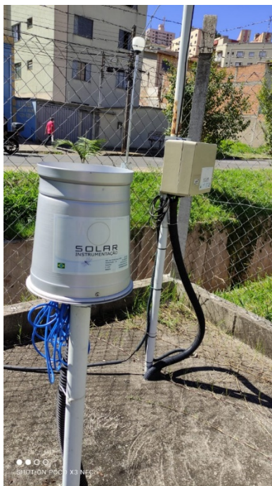
Fotografia 2 - Equipamentos da estação.
