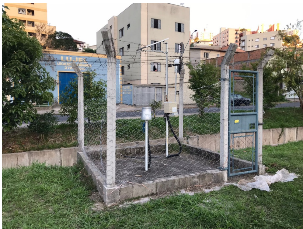
Fotografia 1 - Visão geral da estação AVIRR.
