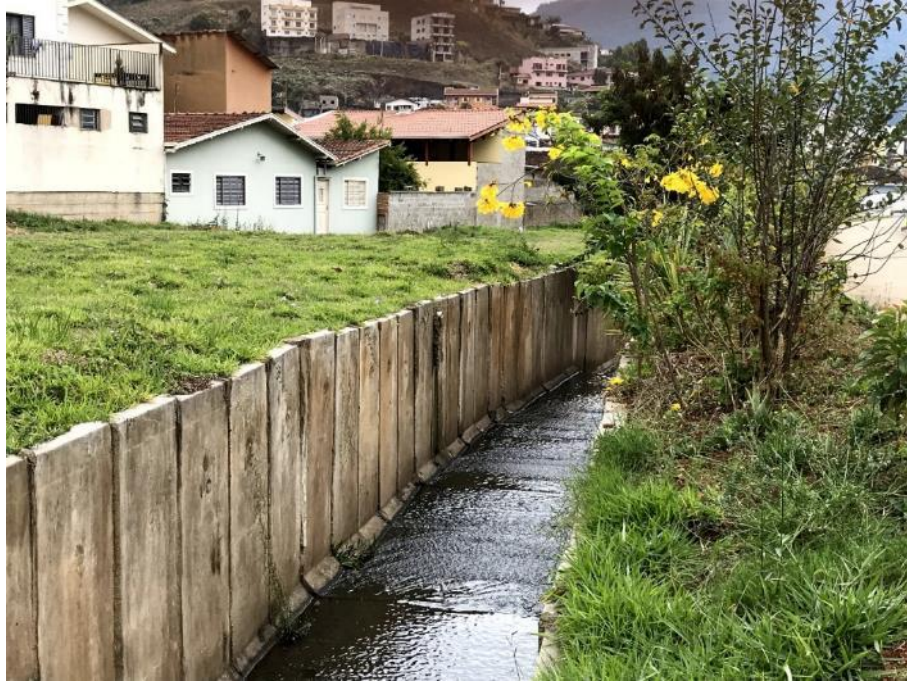
Figura 3 – Canal de concreto (T2)
