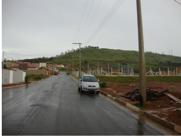
Figura 3 - Detalhe da condição das vias do loteamento.
