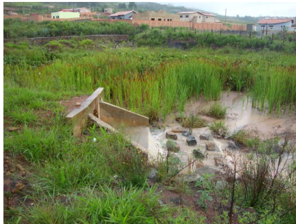
Figura 4 - Detalhe da Bacia de Detenção.
