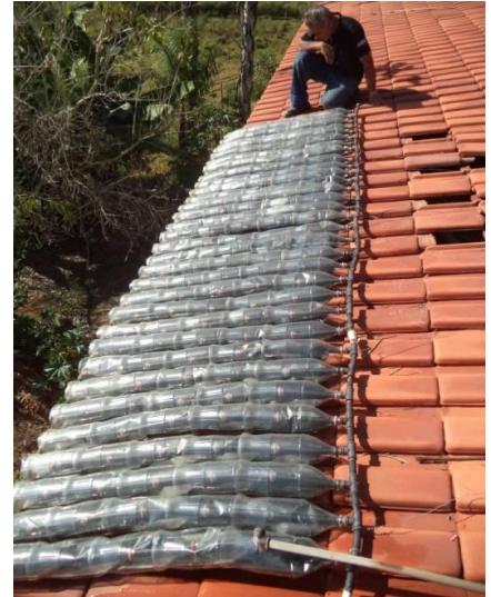
Figura 5 – Sistema de Aquecedor Solar de Baixo Custo. Fonte: da autora
