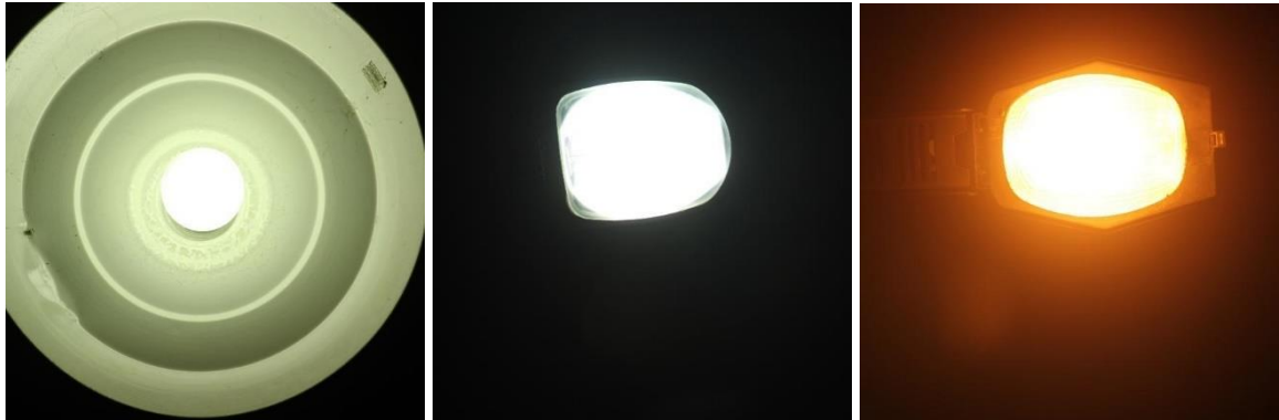
Figura 22 - Fotos de três tipos distintos de lâmpadas de pontos de iluminação pública: MV (esquerda), MH (centro) e HPS (direita).
