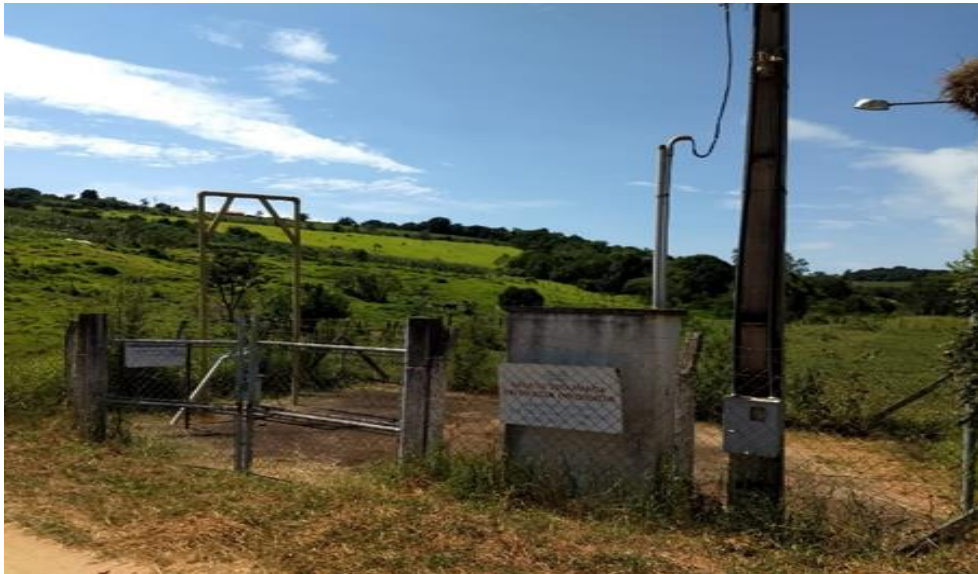
Figura 30: Estação de captação em um ponto do Córrego da Lagoinha ponto (b)
