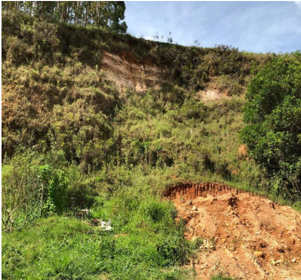
Figura 36: Recorte de talude às margens do rio.
