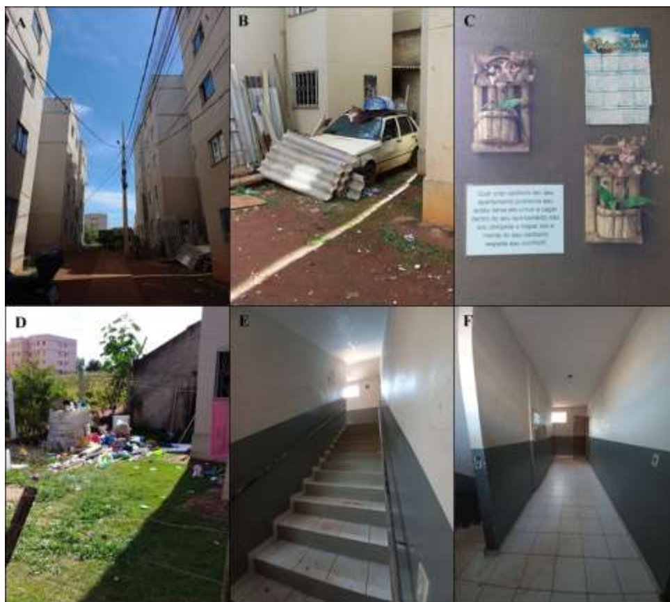
Figura 23 - Situação dos blocos em relação à limpeza nos Residenciais Alfenas e Jd. São Carlos.
