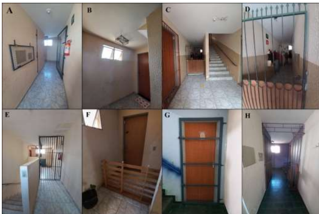
Figura 16 - Instalações de grades entre corredores, andares e apartamentos nos Residenciais Jd. das Alterosas e Vale do Sol.
