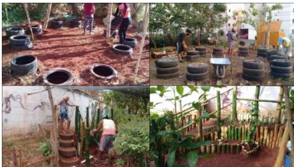
Figura 34 - Construção do espaço de socialização na horta
