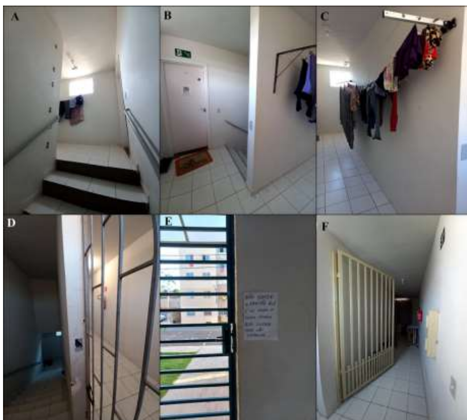
Figura 24 - Presença de varais improvisados e instalação de portão no Residencial Tupã.
