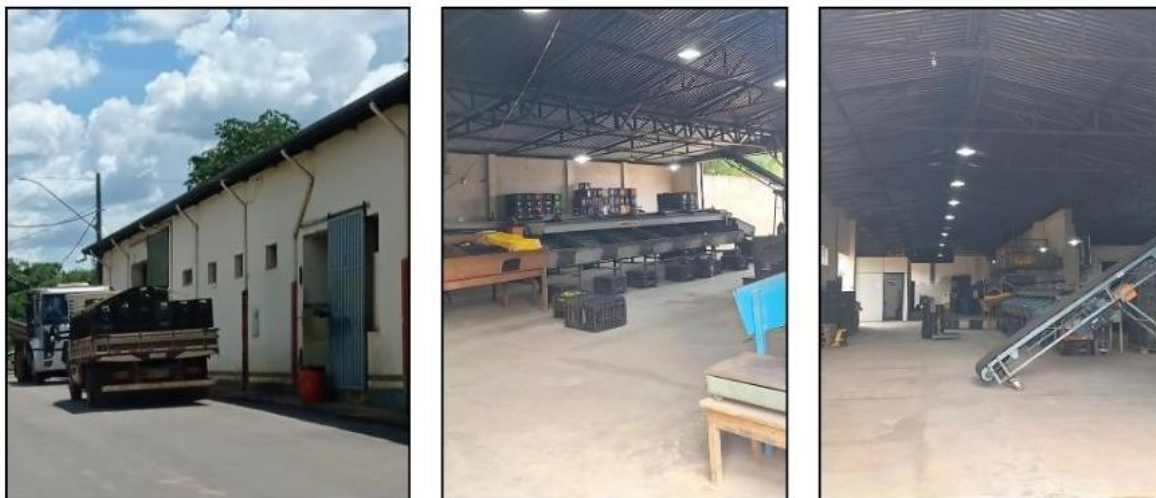
Figura 26 - Estrutura interna de um barracão de comércio e beneficiamento de citrus em Campanha.
