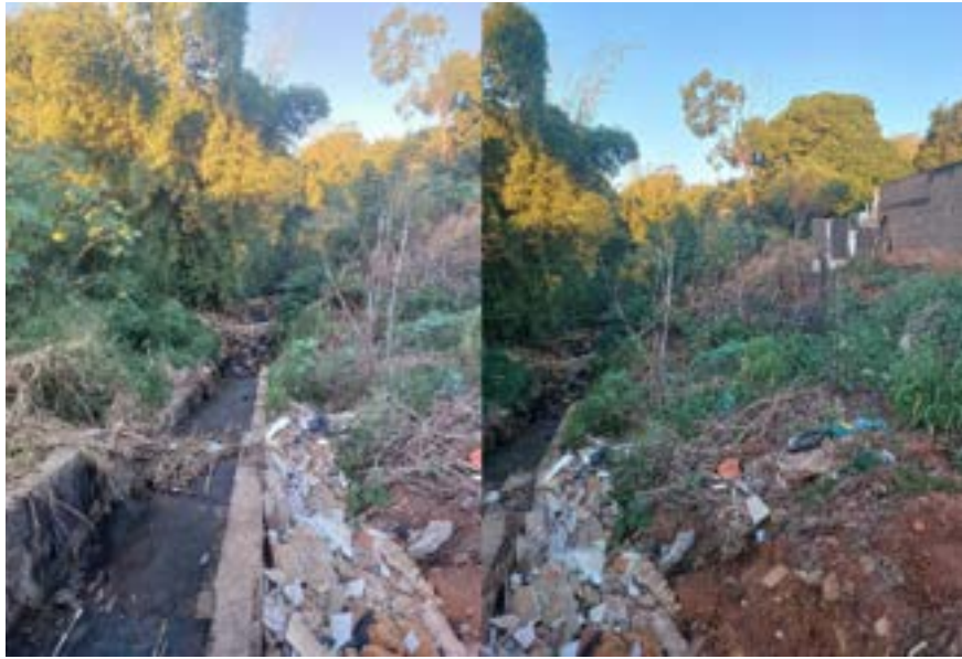
Figura 7: Trecho 1 Ponto 2 do Córrego do chafariz (Foto do autor)
